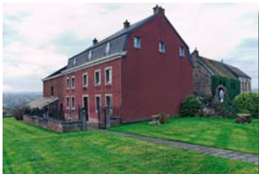
Large et profonde habitation en briques et calcaire sur soubassement de moellons cimenté.
